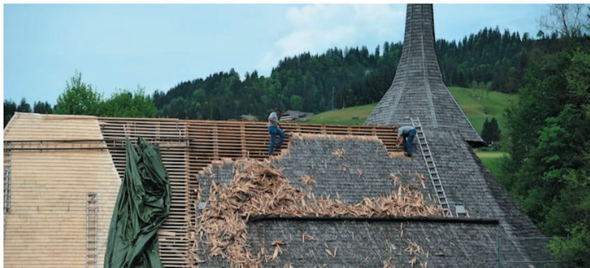
Die alten Holzschindeln und Latten wurden zuerst sorgfältig entfernt.
