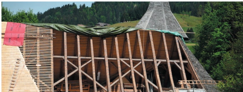
Die alten Holzschindeln und Latten wurden zuerst sorgfältig entfernt.
