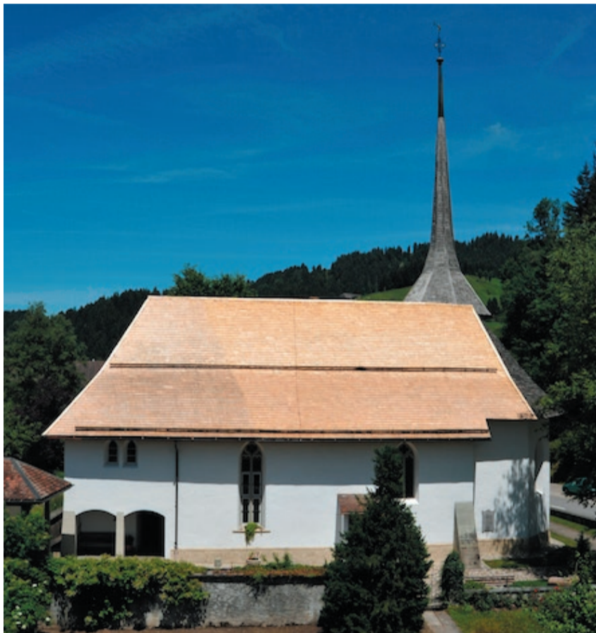
Ende Juni wurden die Sanierungsarbeiten abgeschlossen.
